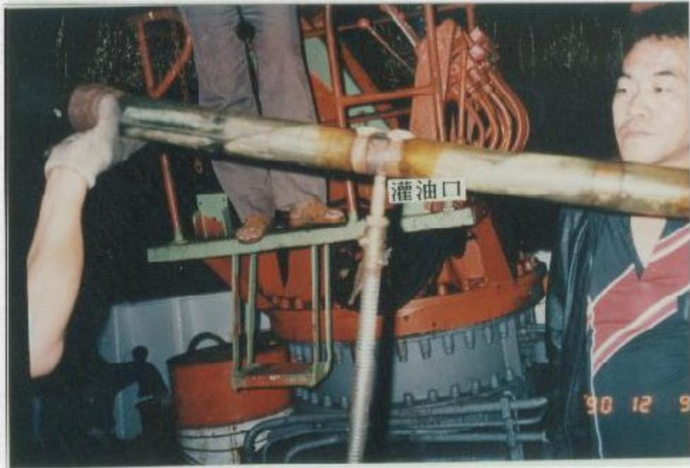
在水中受波器施放時必須檢查每節內是否充滿油或因破裂漏油？若有漏油則必須補漏，管內油若太少必須用灌油馬達將Isopar M 之石油溶液經由灌油孔將油打入管內。（上圖為灌油實景）
